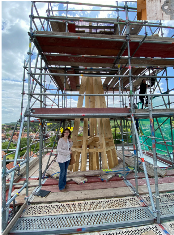
Foto 6: Ramona Kubal – Mauerseglerpflege Mauerle e. V. . Z. Z. erfolgt die Klärung der Nistmöglichkeiten nach Fertigstellung des Turms.
